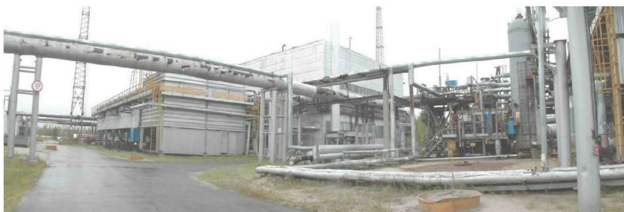
Установка выделения и стабилизации углеводородного конденсата
